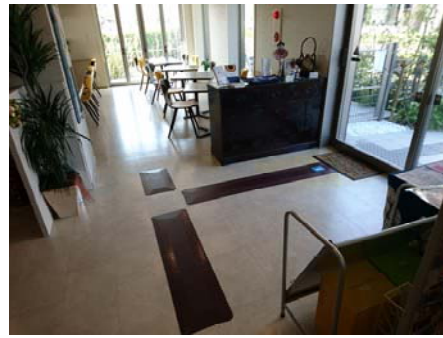
写真② 床とのコントラストが取れる茶色を採用 店内の雰囲気ともマッチしている
